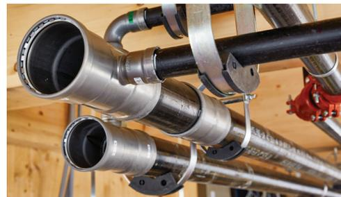
MegaPress conecta el sistema de rociadores contra incendios y en las líneas de gas natural se han utilizado accesorios MegaPressG.
